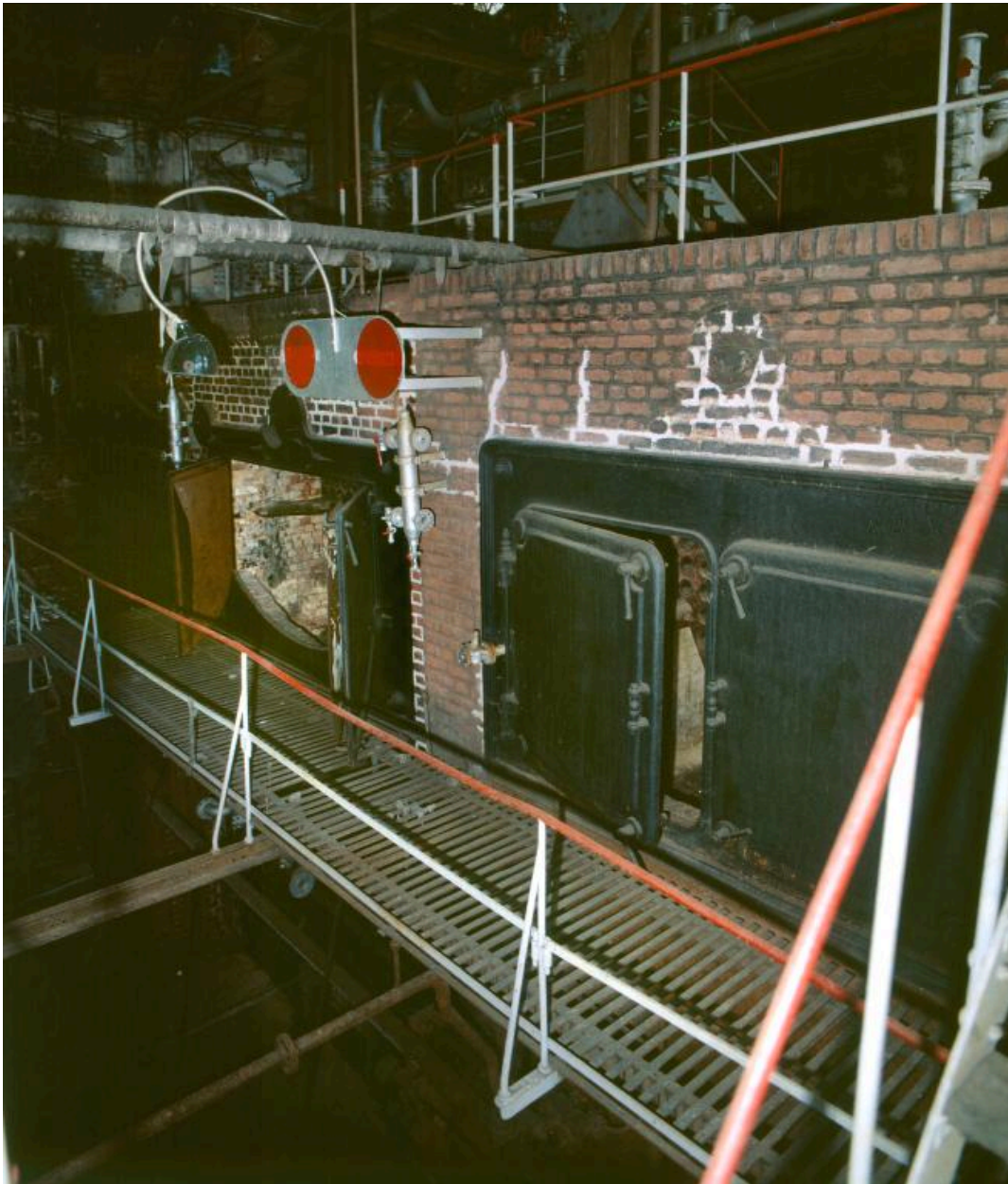
Niveau intermédiaire, vue des fours.
