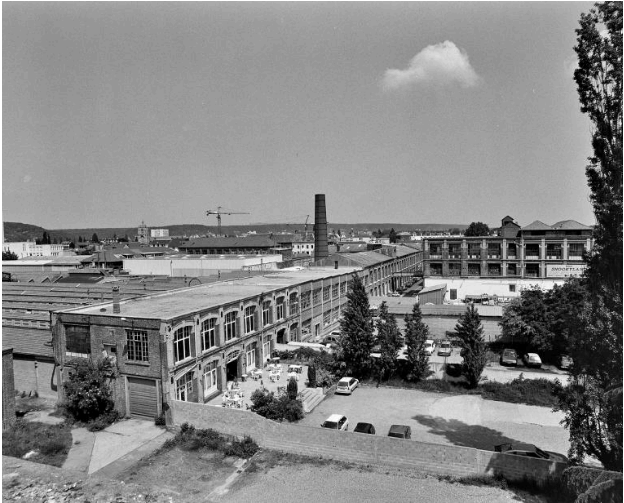
Vue générale de l'usine depuis le Sud.
