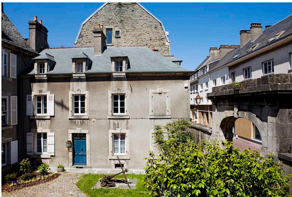
Aile droite côté rue.
