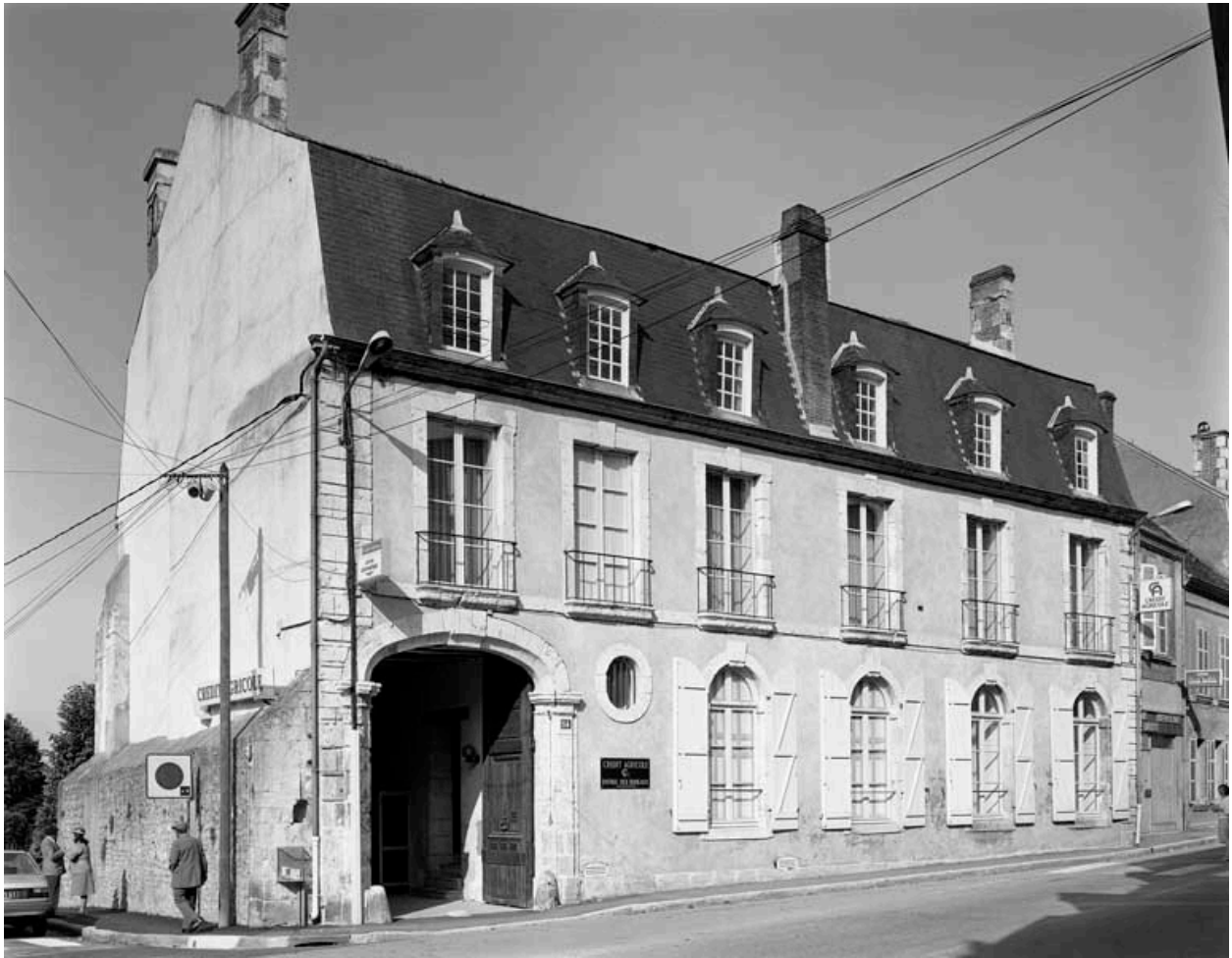
Élévation extérieure sur rue.
