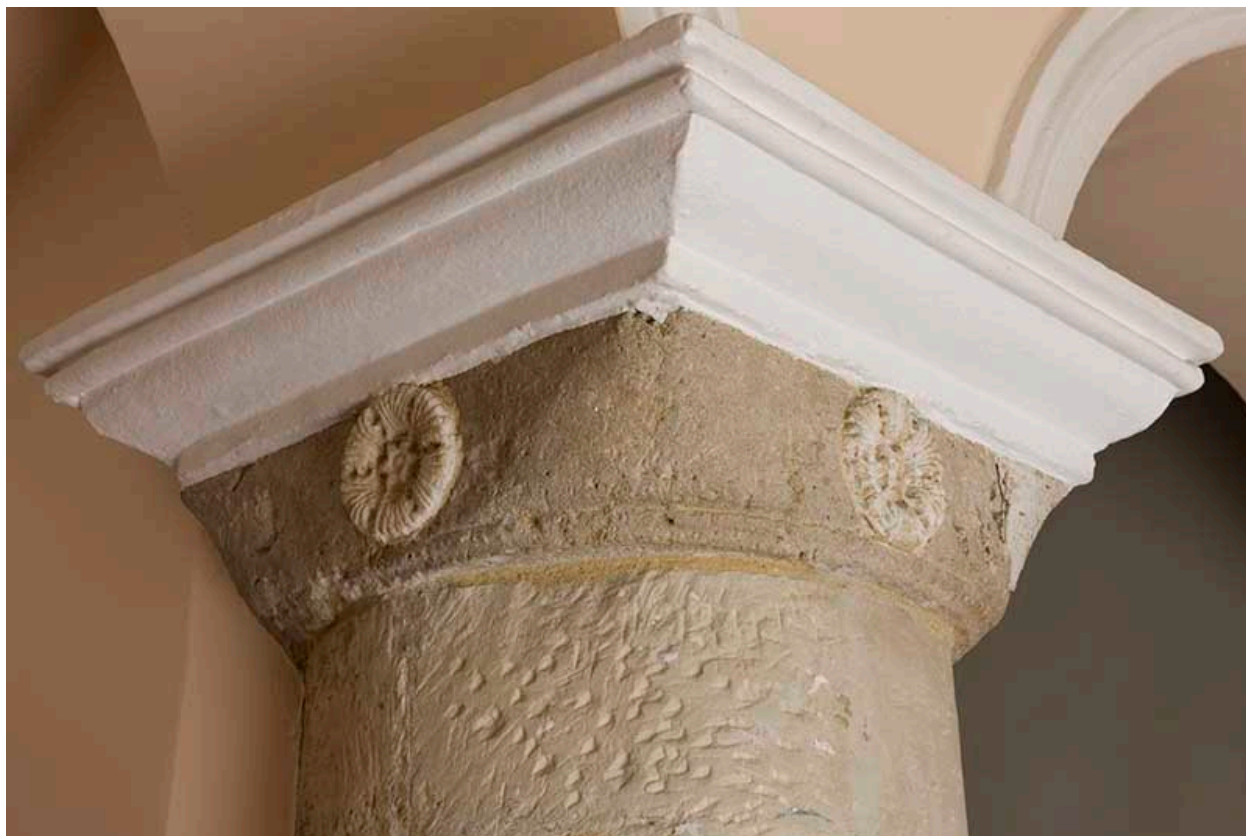
Chapiteau de l'escalier.
