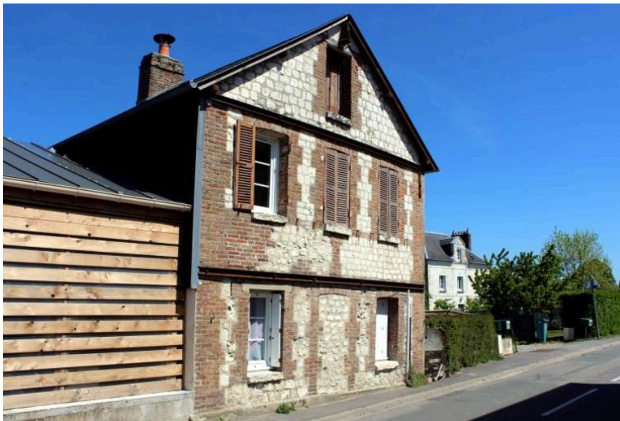
Maison du bourg, 47, rue du Petit Village.
