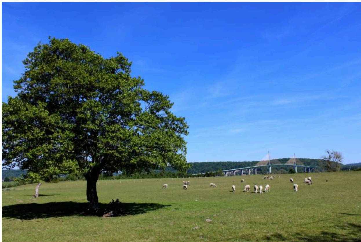
Vue sur le pont de Brotonne depuis les hauteurs du hameau d'Ectot.
