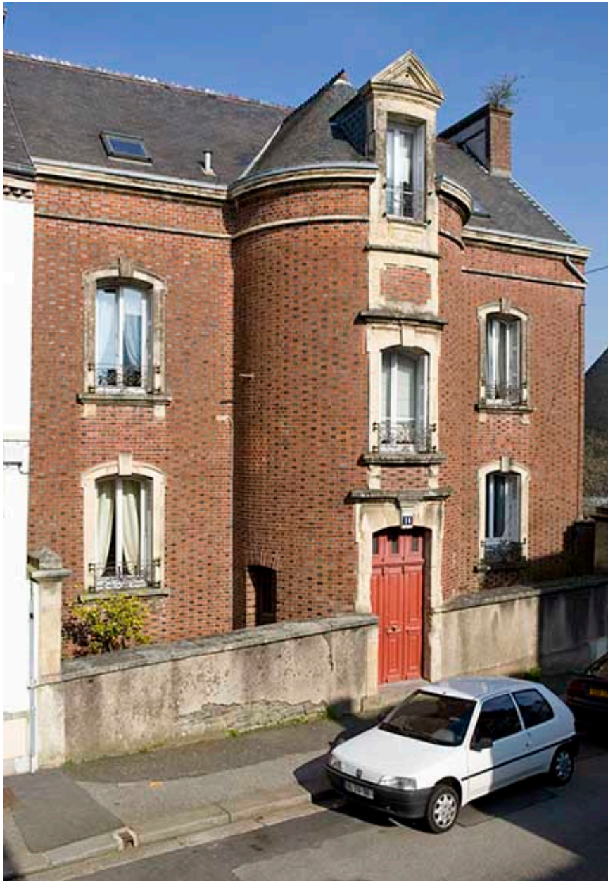
Maison. 14 rue du maréchal Leclerc. Façade sur rue.
