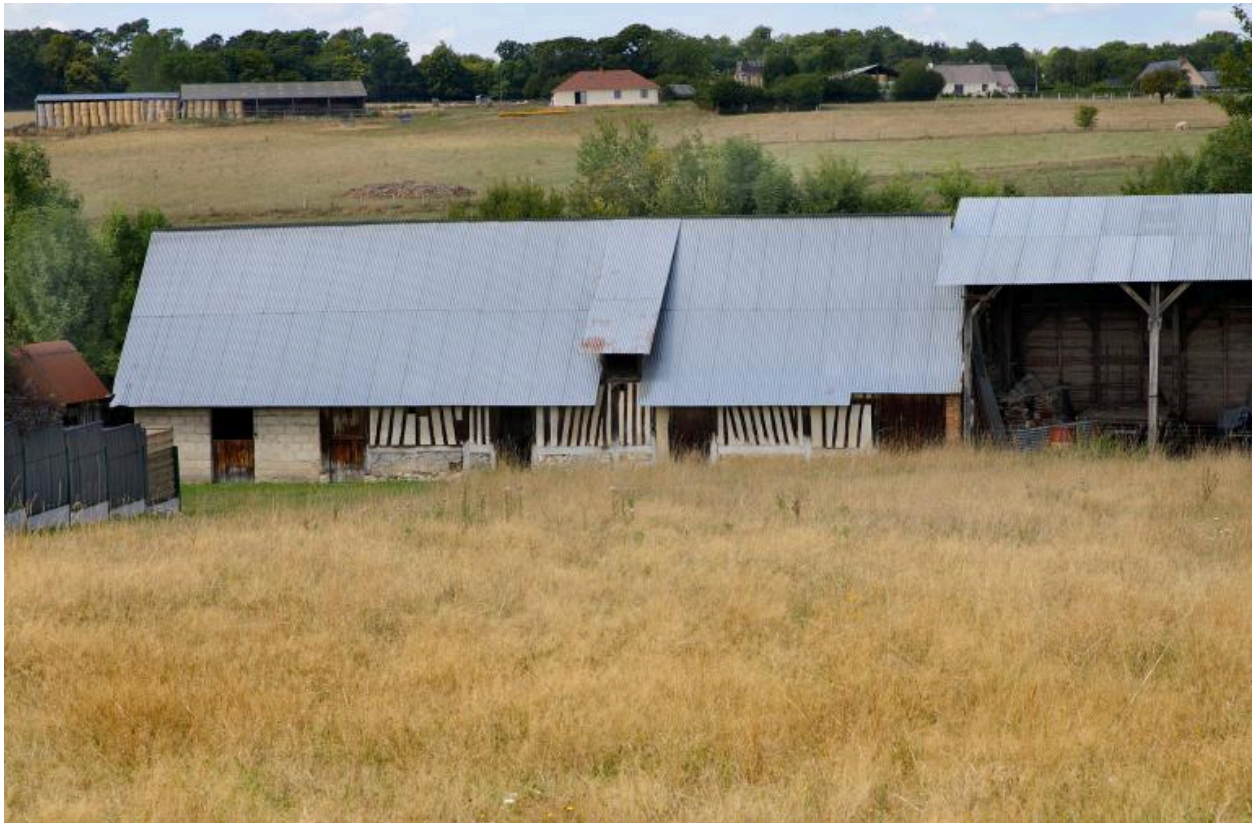
Ancienne étable, 970 rue du Wuy.
