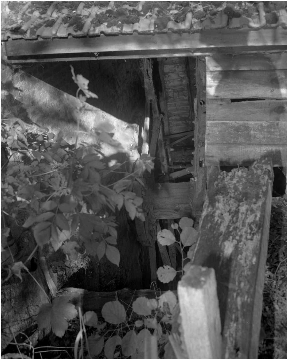
Détail de la roue hydraulique.
