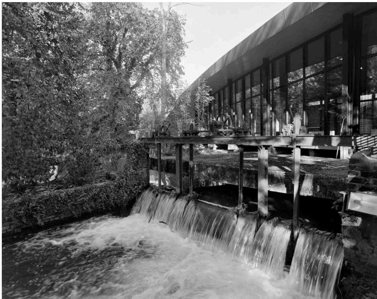
Vannages de décharge.
