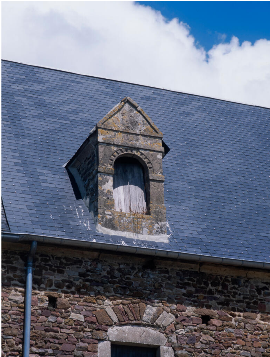
Etable, façade antérieure, lucarne est, vue prise du sud.
