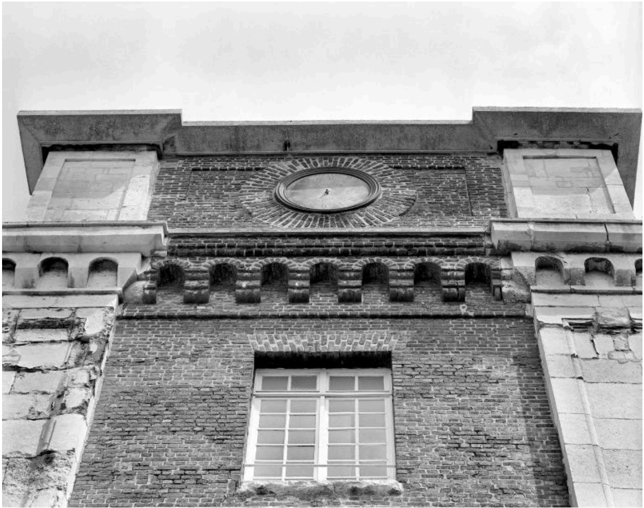
Vue en contre-plongée de la partie supérieure du pavillon Sud de la filature.
