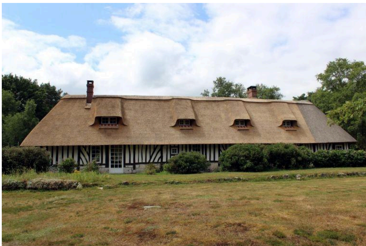
Chaumière entièrement remontée, façade nord-est, 1255, rue des Bruyères.
