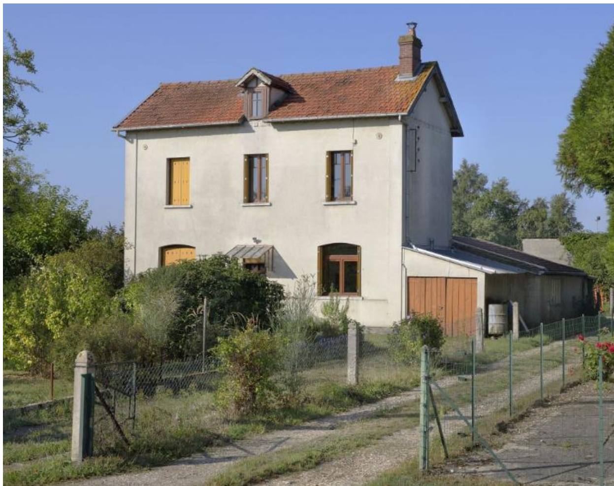
Maison, 1034, rue du Petit Village.
