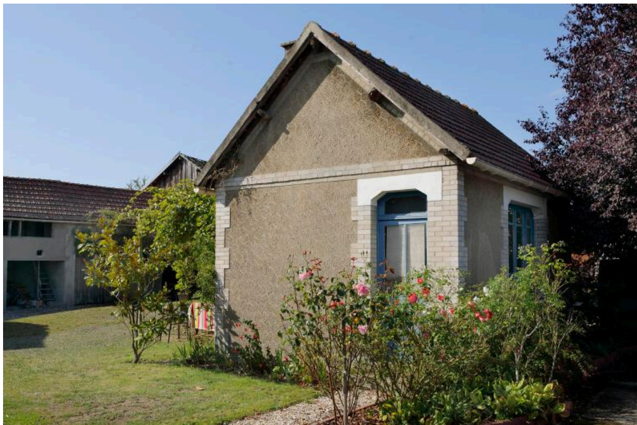
Ancien bureau, angle nord-est.
