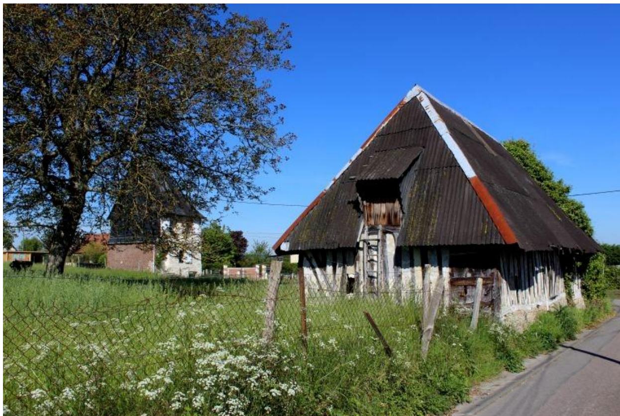
Petite grange, pignon sud.
