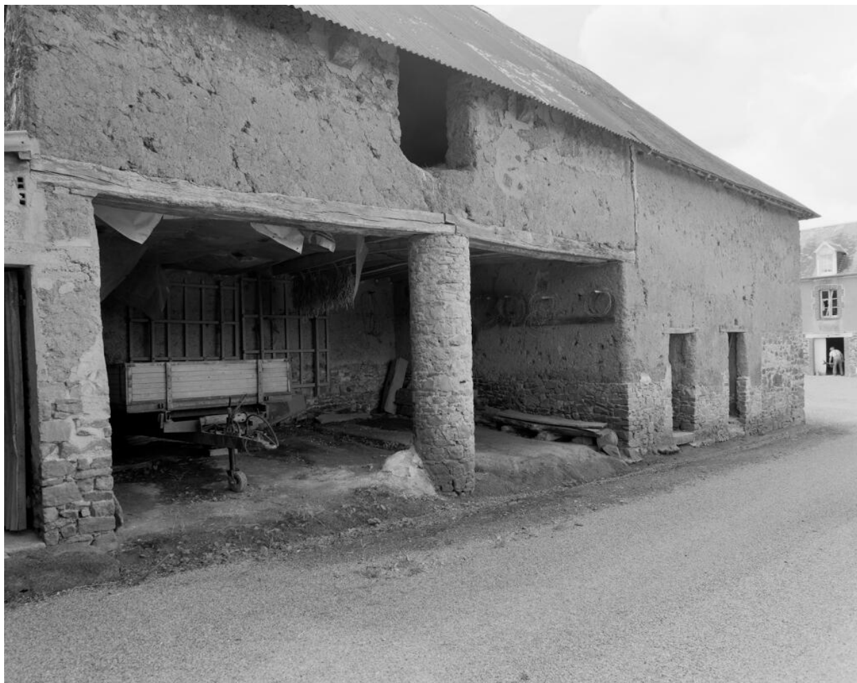
Charretterie, façade antérieure, vue prise de l'est.
