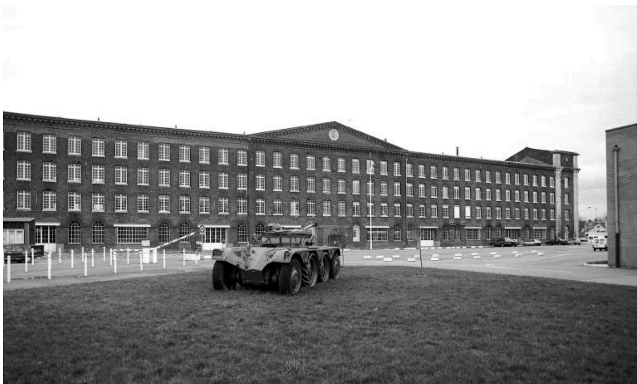
Vue générale de la façade Ouest de la filature, depuis le Sud.
