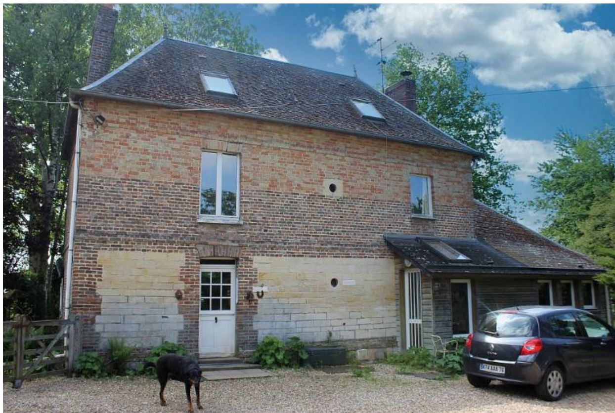
Maison du 19e siècle, façade nord.
