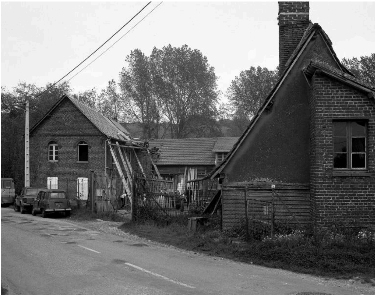
Atelier de polissage (ancien moulin à blé), vue du pignon.
