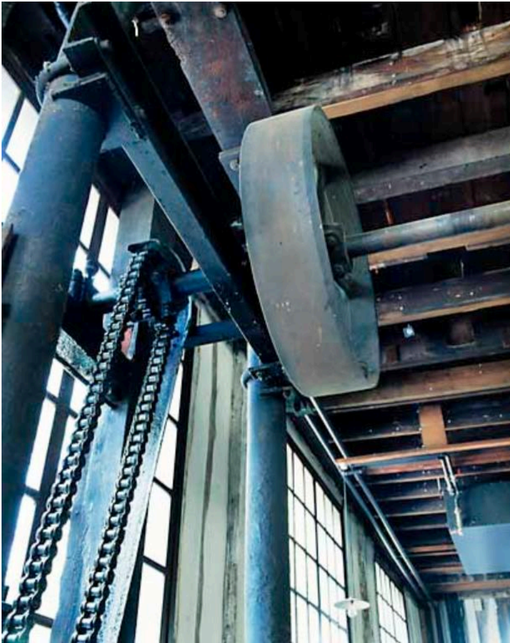
Vue intérieure, premier étage, arbre de transmission.
