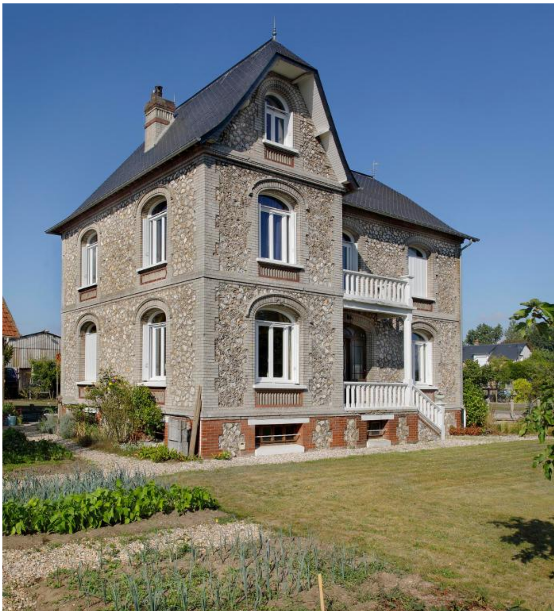
Maison du directeur, angle sud-est.
