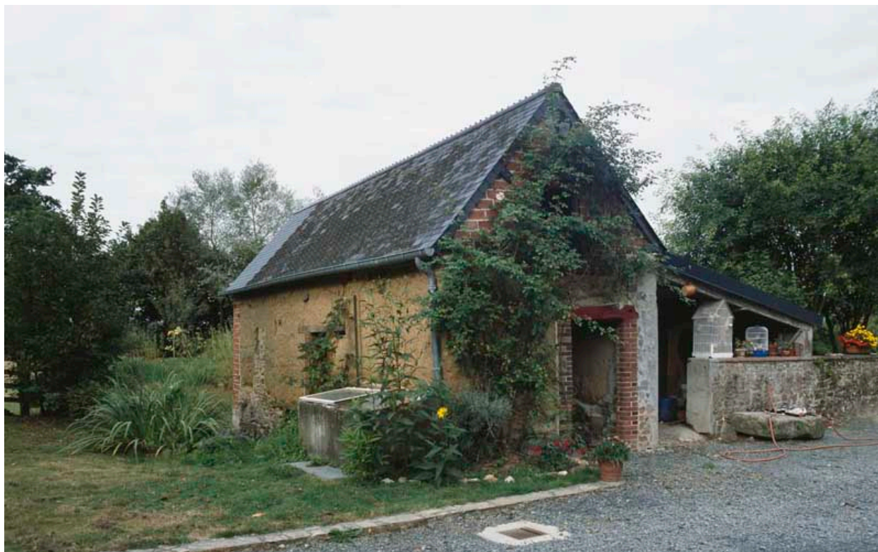
Four à pain, vue prise du sud-est.
