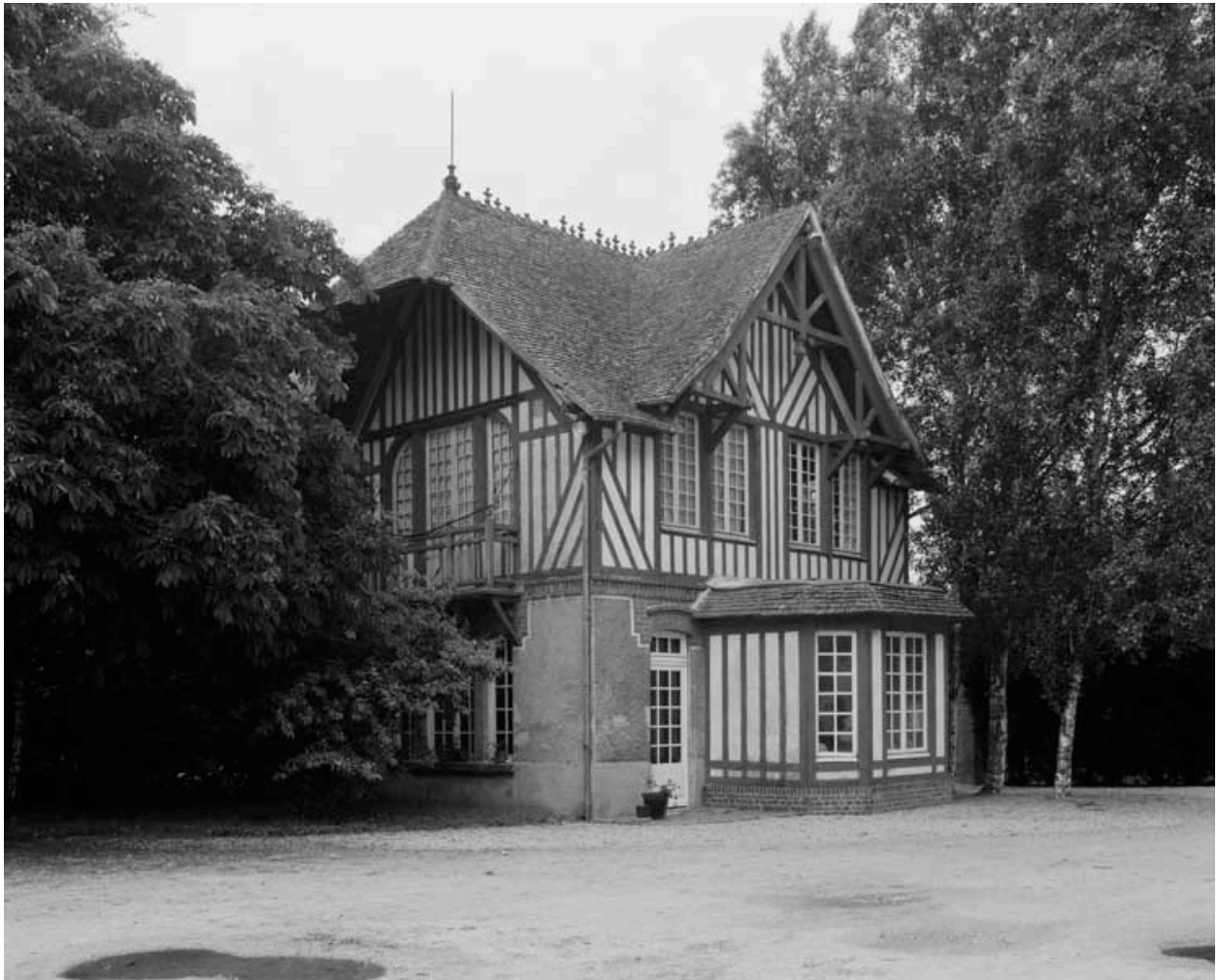
Bureau. Vue prise du sud.
