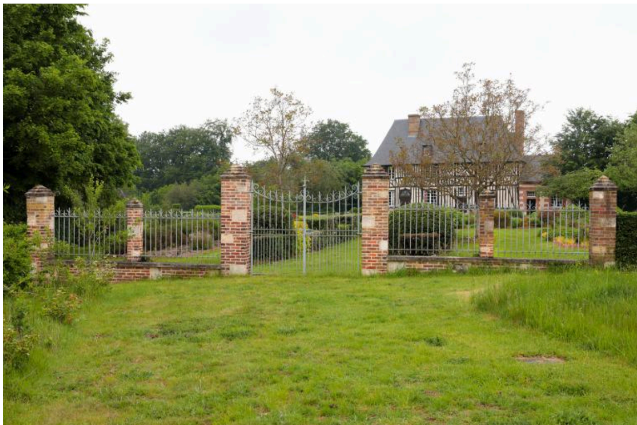
Ancien portail, vu du côté sud.
