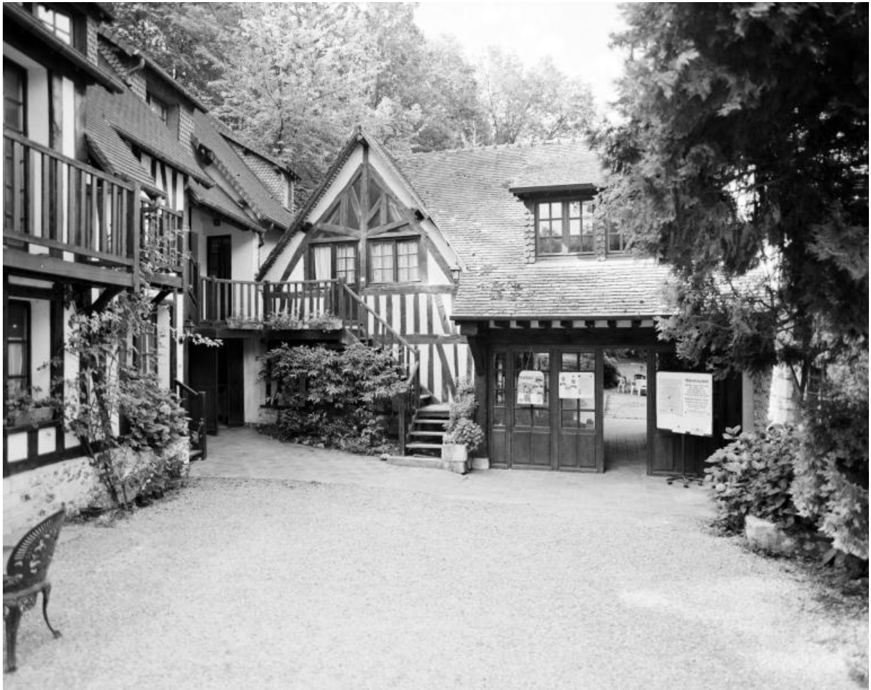
Vue des extensions de la maison du meunier, depuis le Nord.
