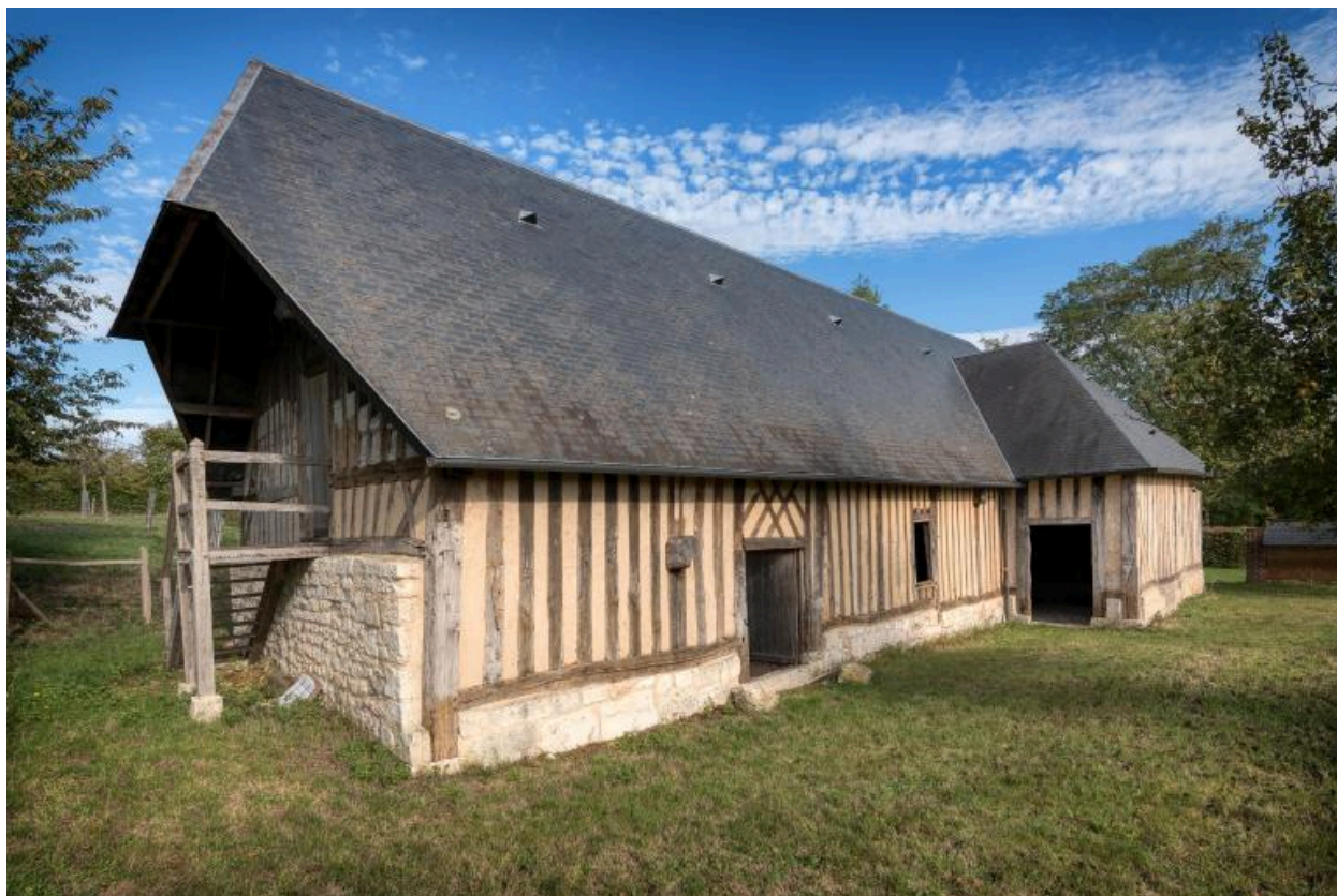
Pressoir, angle nord-ouest.
