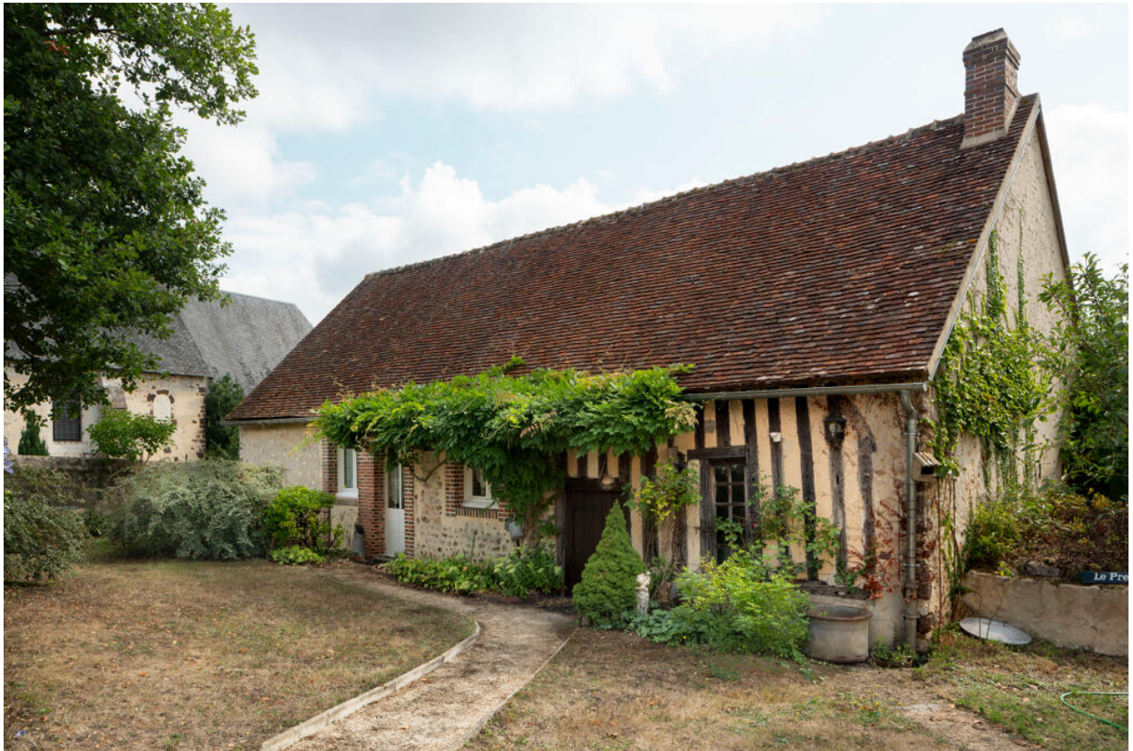
Dépendance nord, vue générale depuis le sud-ouest.
