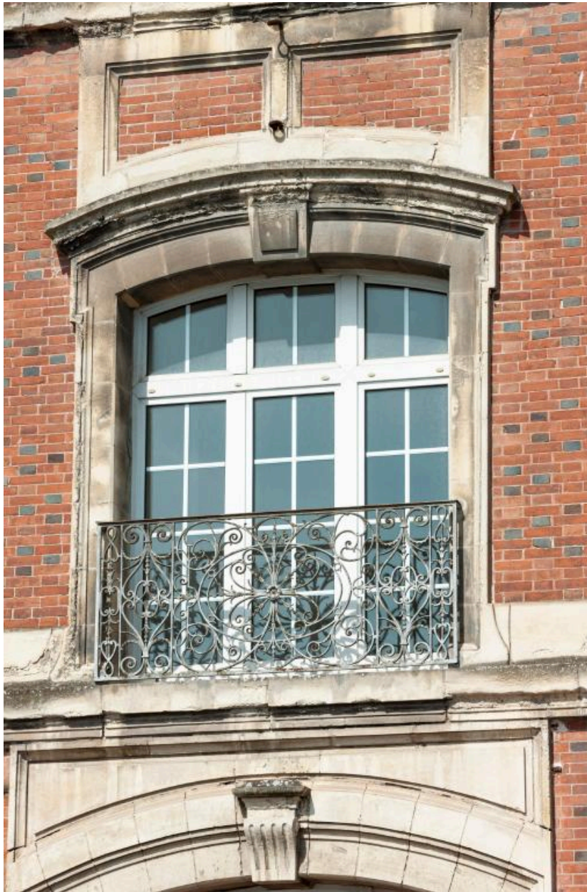
Détail d'une baie de la façade sur rue.
