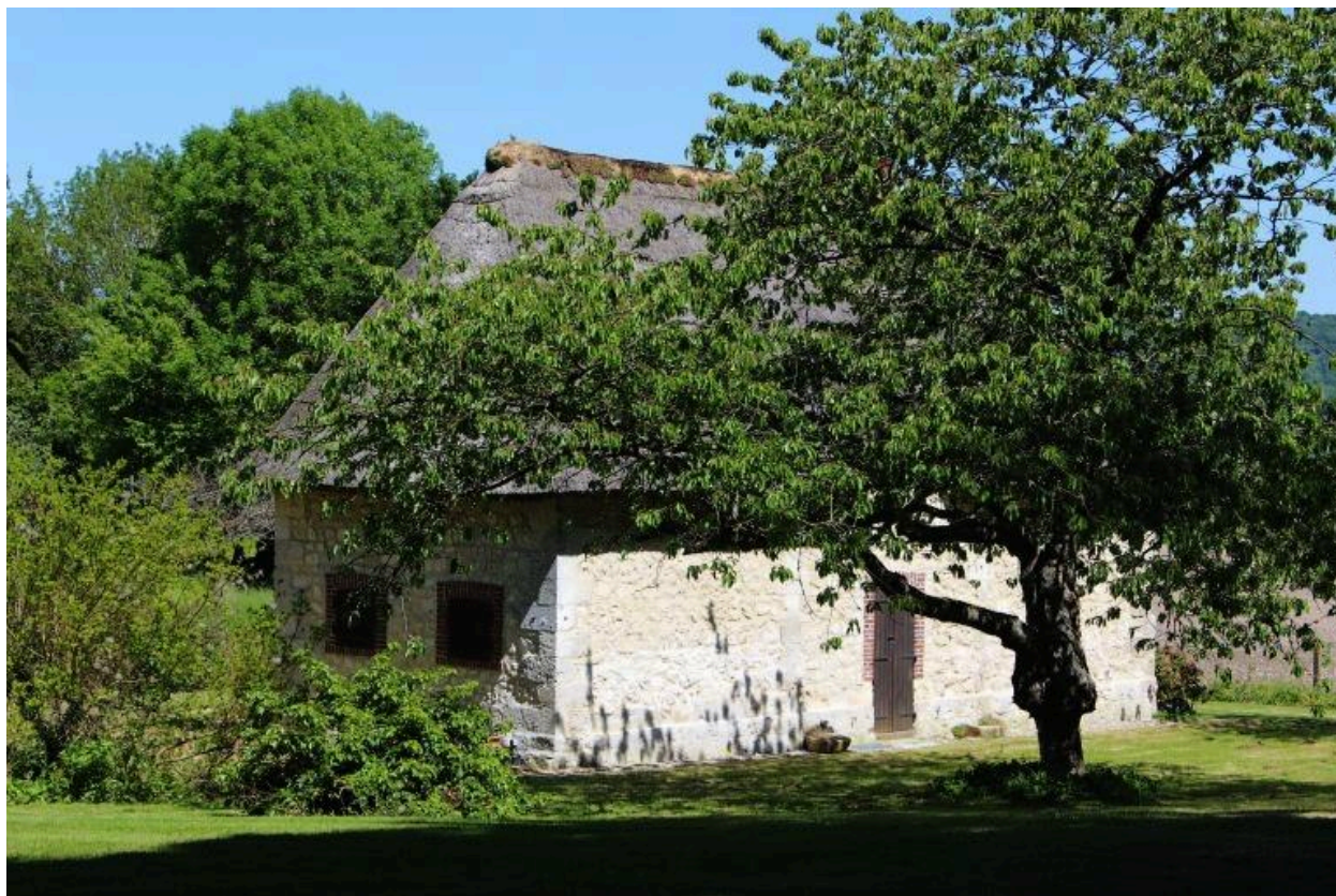
Ancienne étable et maison, vue depuis la route principale.
