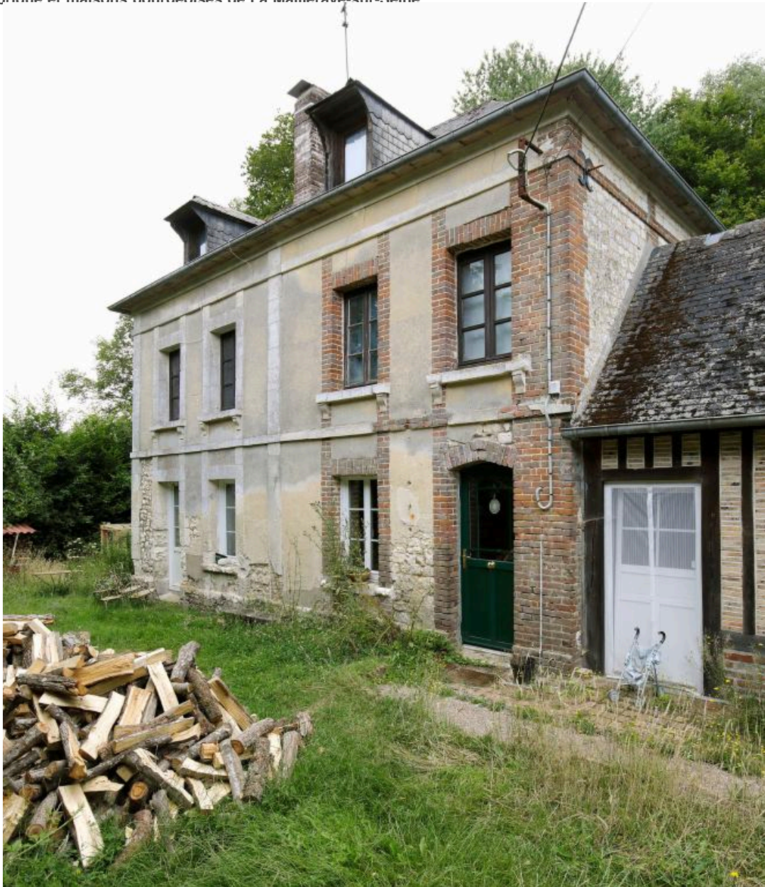
Ancienne maison du garde du marais, en moellons calcaire et brique, 1641, route du Torp.
