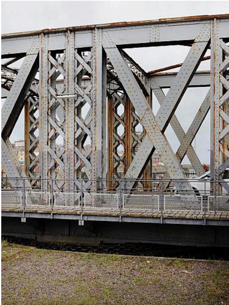
Détail du pont, avec passerelle piéton.
