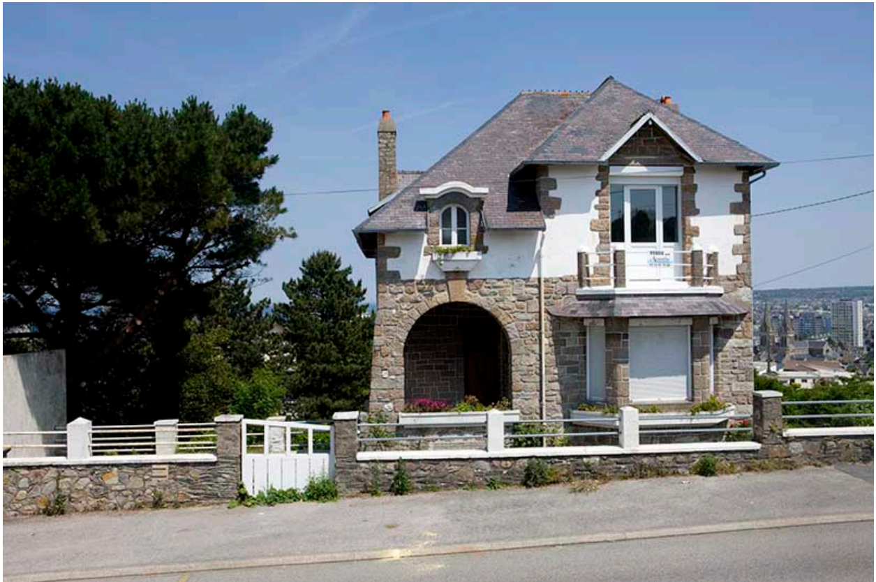
Maison. 153bis rue du maréchal Leclerc. Façade sur rue.
