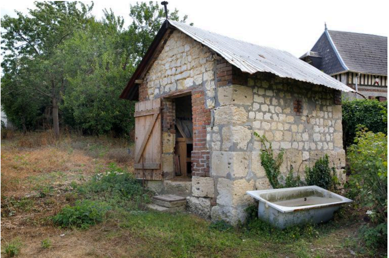
Ancien poulailler, 88 rue du Bourg à Charrol, angle nord-ouest.
