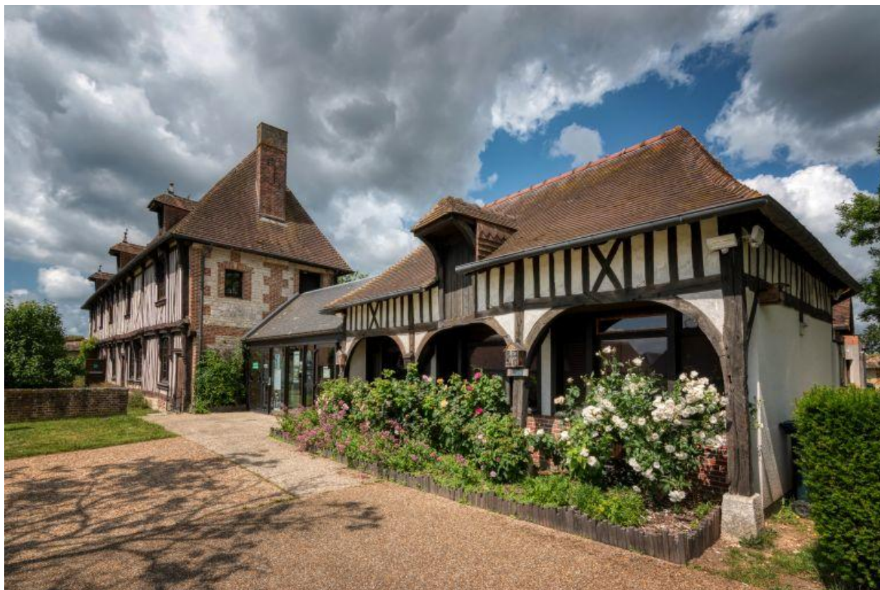
Manoir et charretterie en prolongement, angle sud-est.
