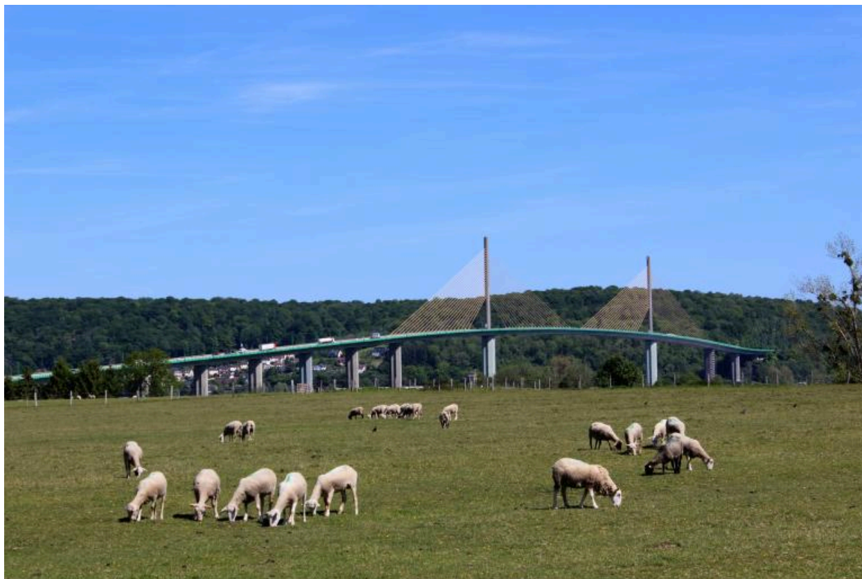
Le pont de Brotonne, vu depuis les hauteurs du hameau d'Ectot.
