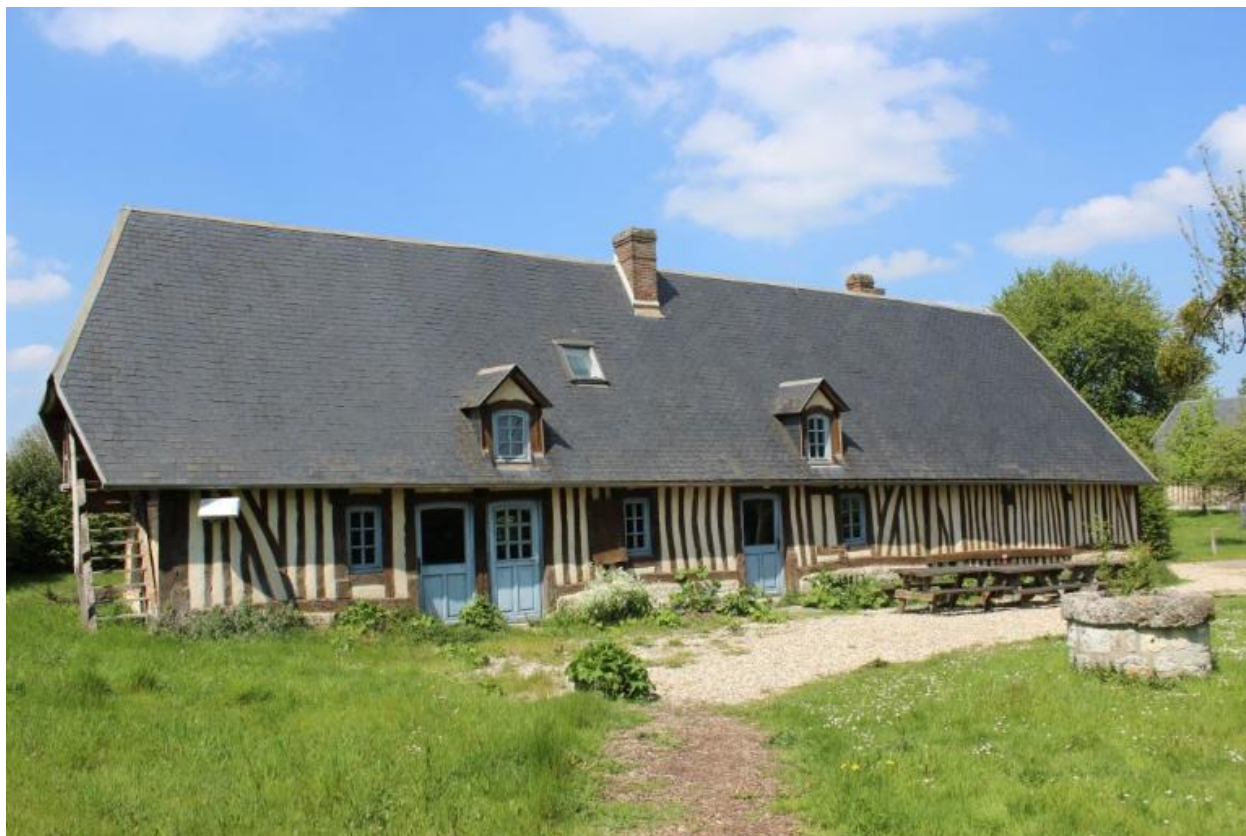
Ancienne maison du fermier, actuellement maison des stagiaires, façade sud.
