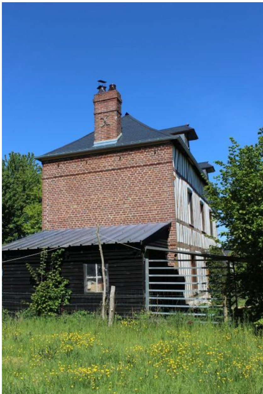
Maison du 19e siècle, angle sud-est.
