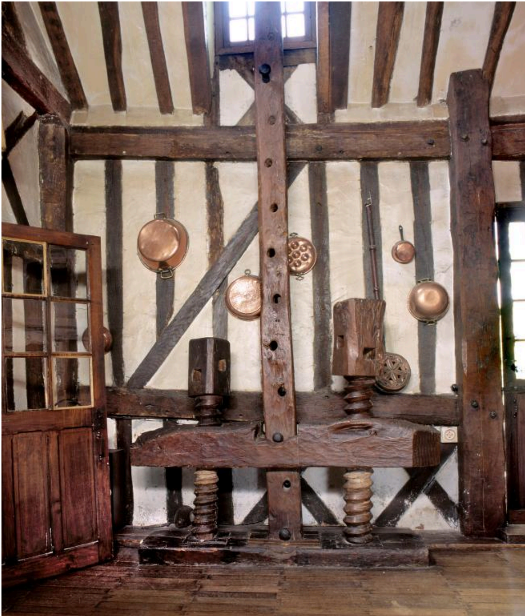
Moulin, vue intérieure de la salle meunière, détail du mécanisme de levage de la roue hydraulique.
