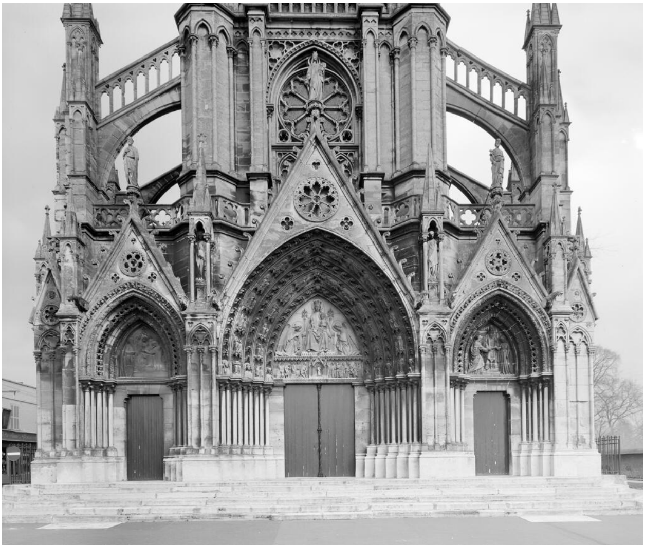
Façade occidentale, portails (1968).
