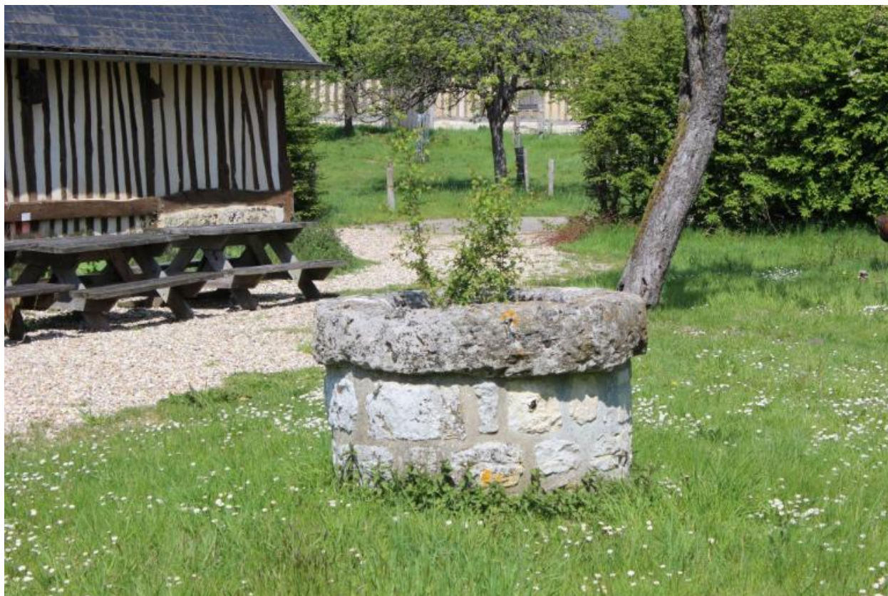
Puits situé à proximité de la maison des stagiaires.
