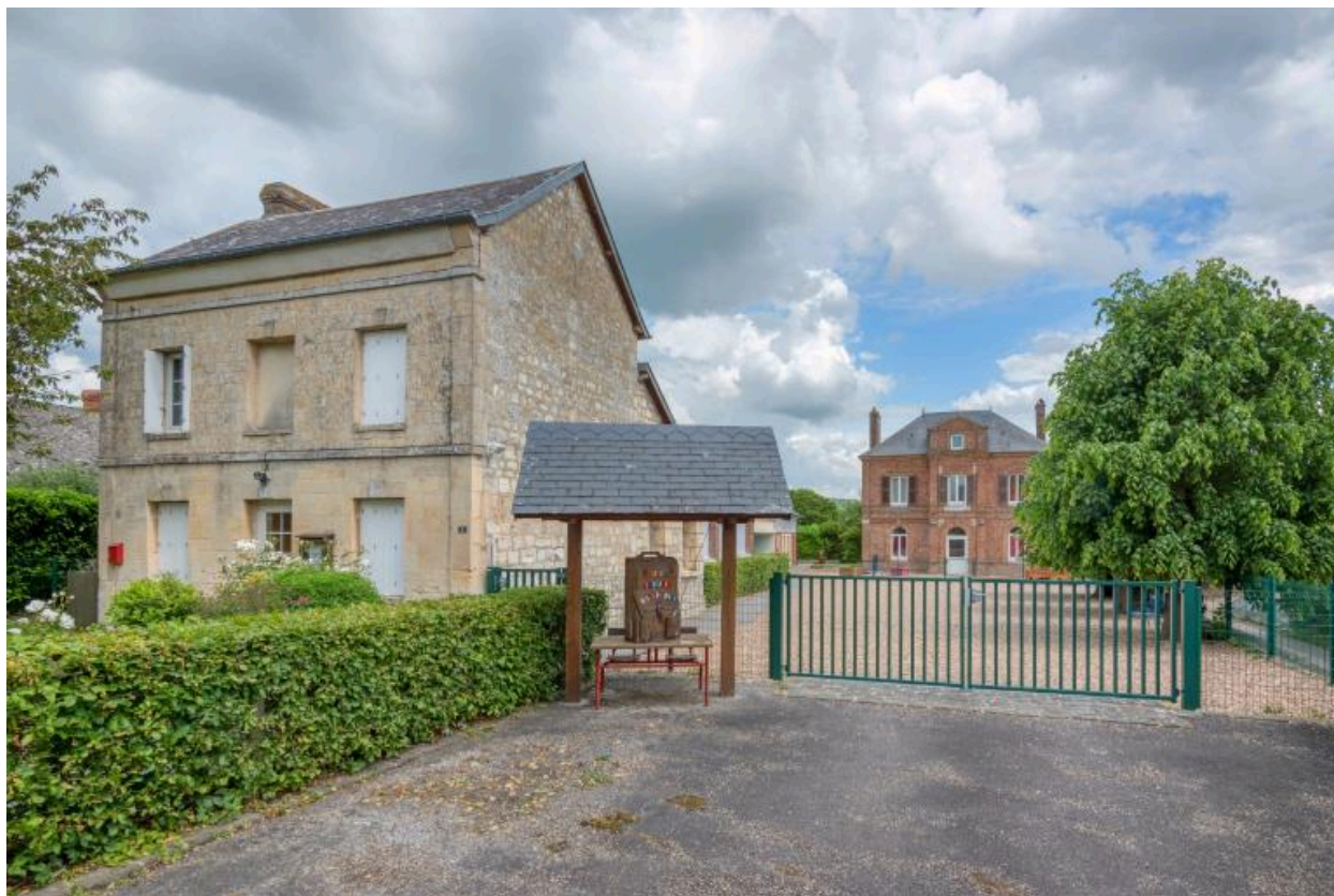
Vue d'ensemble depuis la route principale.
