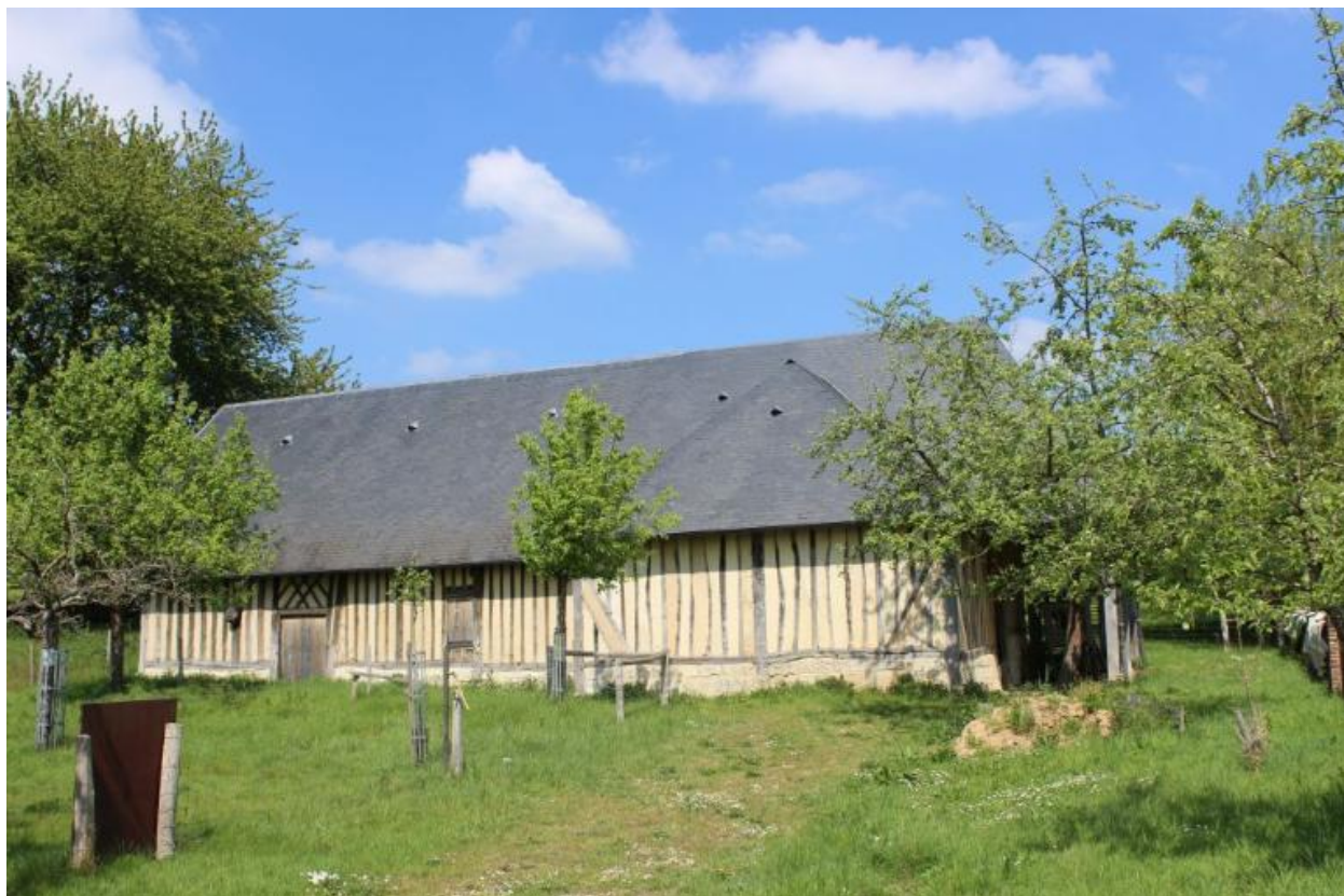
Pressoir, façade ouest avec agrandissement.
