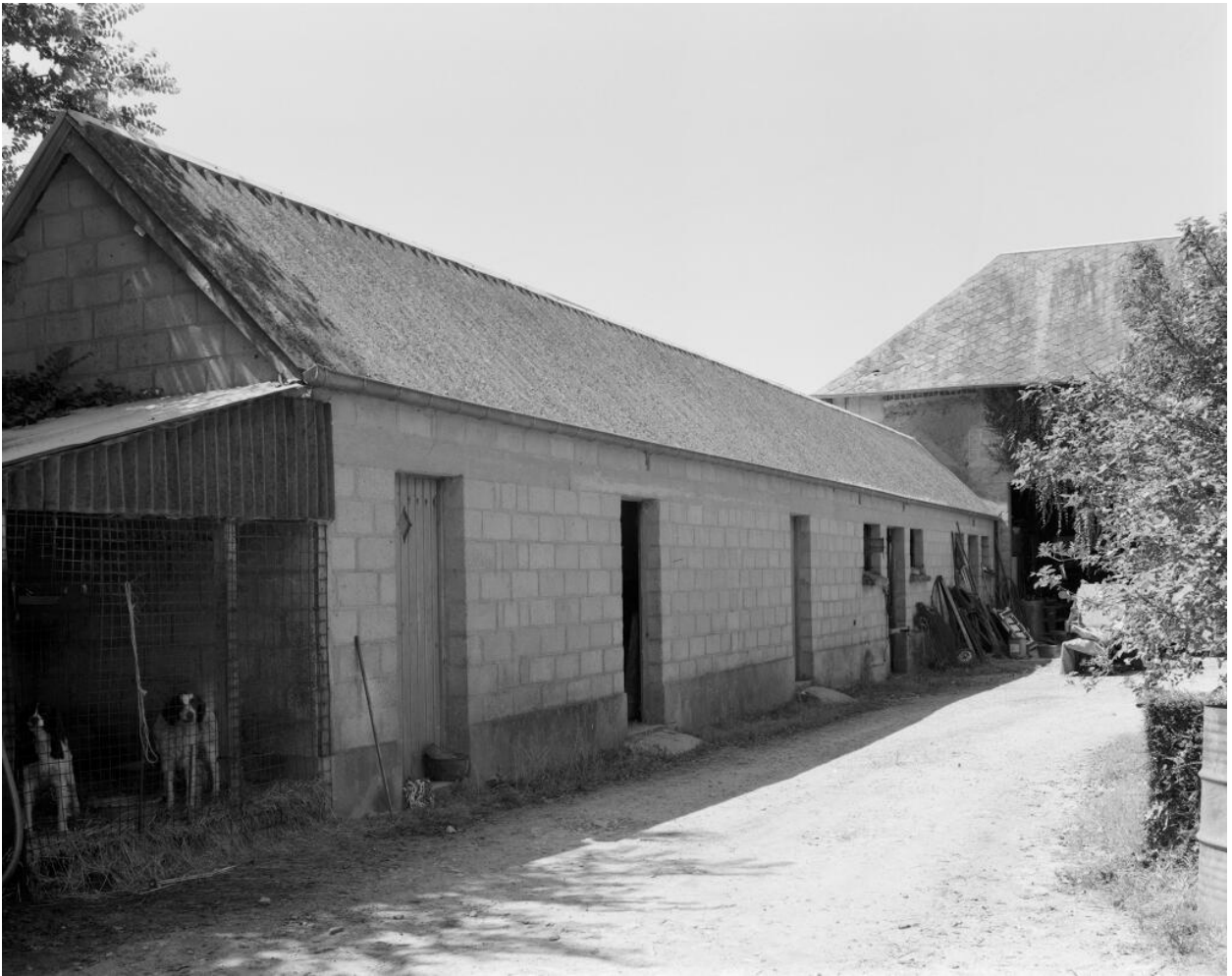
Etables ouest, façade antérieure, vue prise du sud-est.
