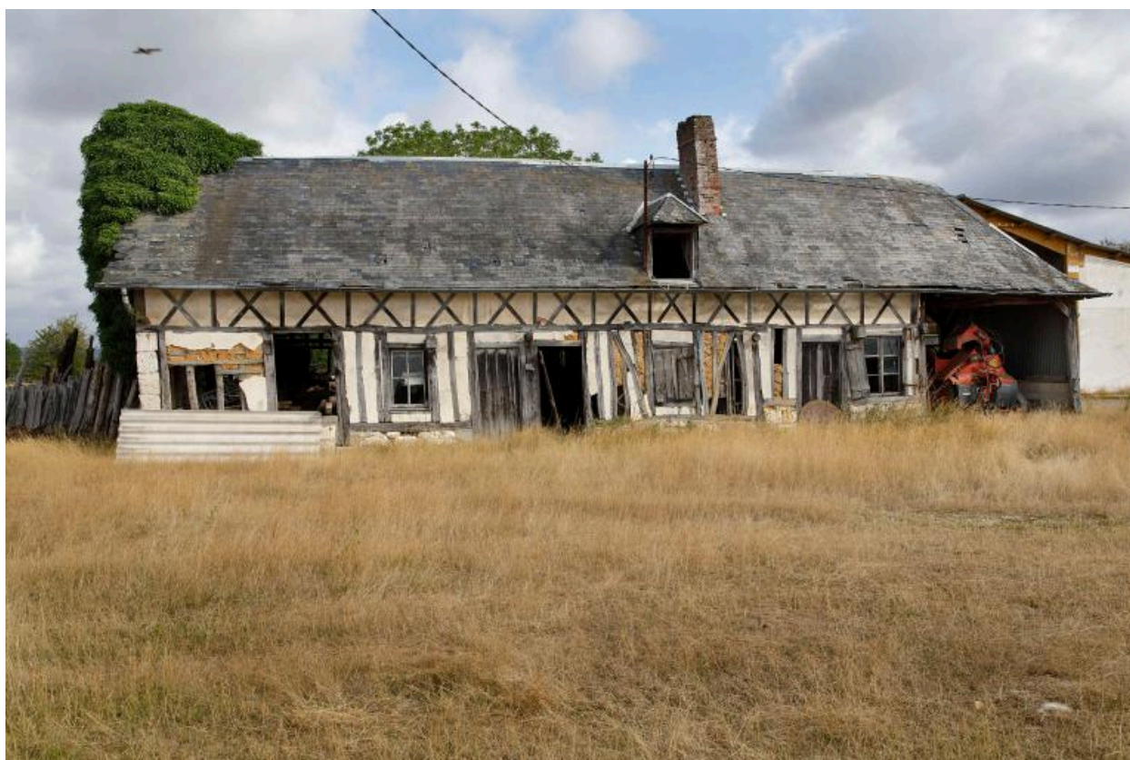
Ancienne maison de ferme et charretterie attenante, 68 chemin du château.
