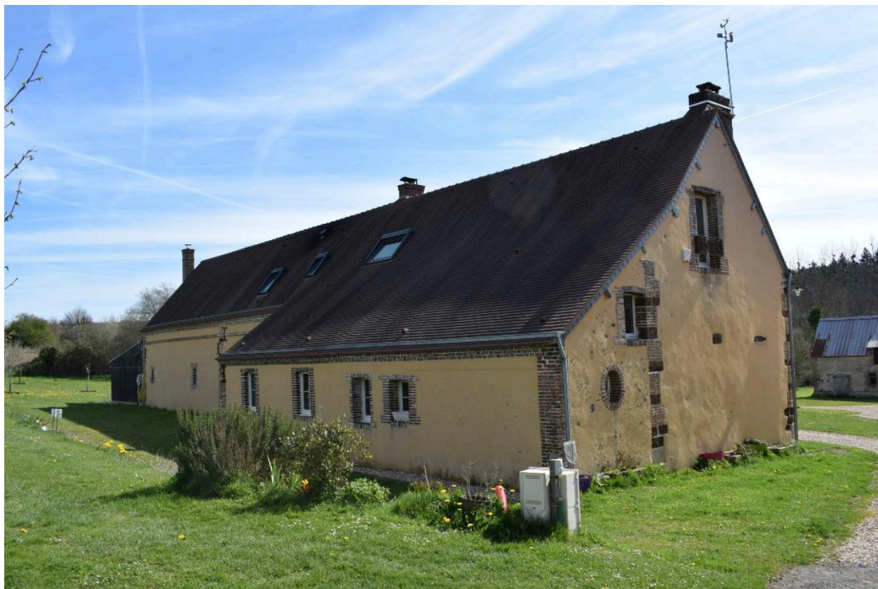
bâtiment d'habitation, vue d'ensemble depuis l'ouest.
