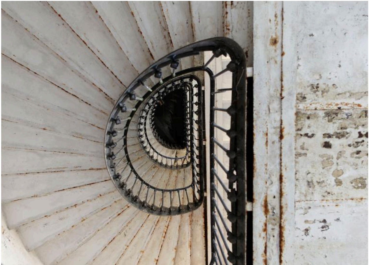
Vue intérieure de la filature, vue en plongée de l'escalier Sud.
