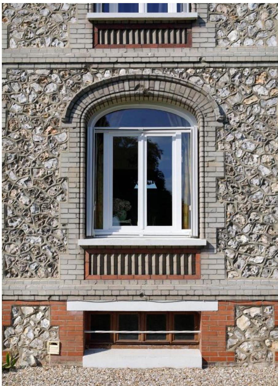
Maison du directeur, détail d'une baie.
