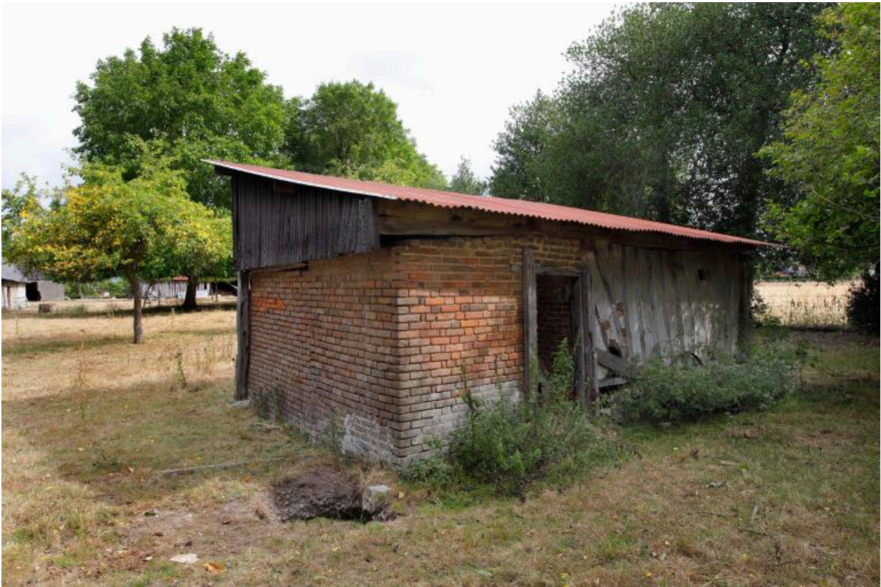
Ancien four à pain, 431 chemin du château, angle sud-ouest.
